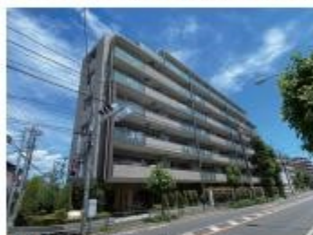
■外観 (メインゲート側)
